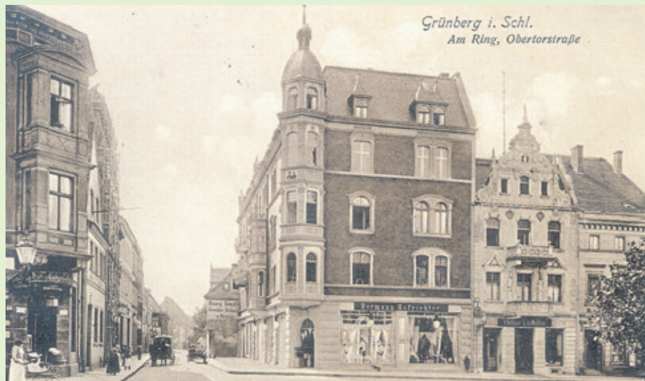
Narożnik dzisiejszej ul. Sobieskiego i Starego Rynku. Pożar strawił wnętrze dawnego sklepu. Wypalony budynek stał przez kilka lat. Dzisiaj jest tu bank. Zbiory biblioteki UZ
