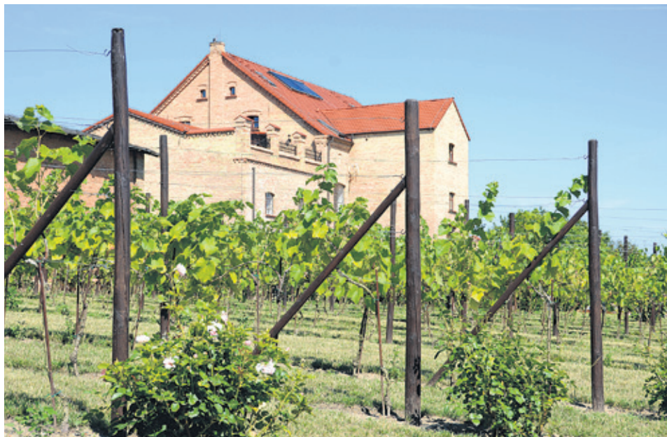
Winnicę Folwark Pszczew założono na tyłach budynku odrestaurowanej gorzelni
