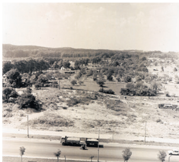
Po drugiej stronie Gwardii Ludowej w przyszłości powstanie ul. Węgierska
