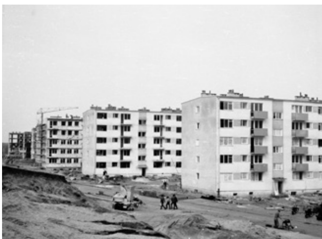
Budowa domów przy ul. Ptasiej
