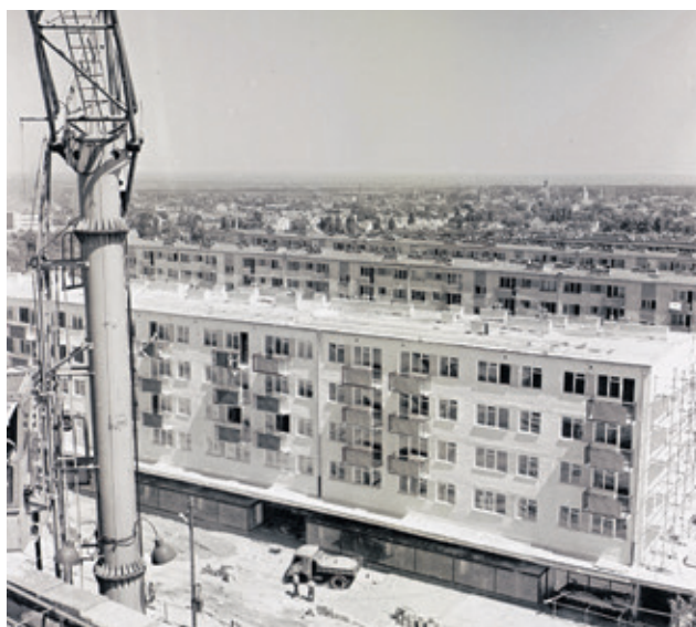
Budowa bloku przy ul. Gwardii Ludowej
