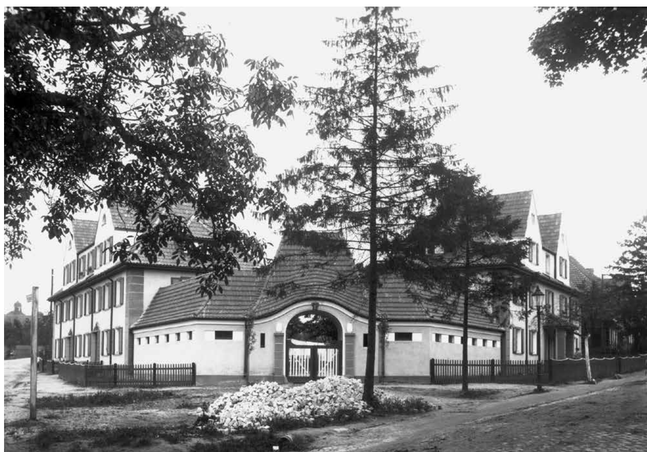
Budynki zostały zbudowane w 1925 r. Z dwóch strony bramy znajdują się komórki.
