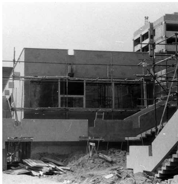
Widok budowanego Topazu od strony poczty
