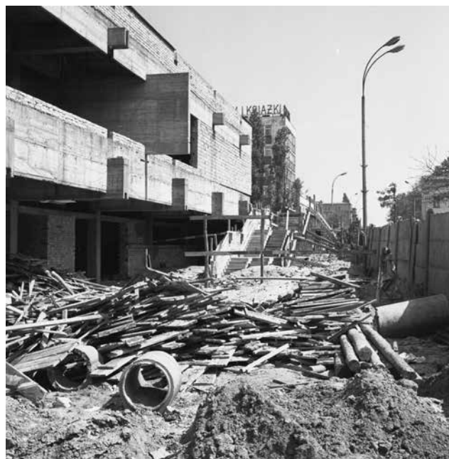
Rok 1972 - budowa lokalu
