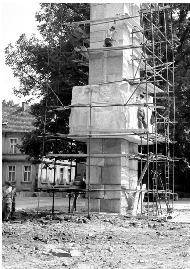
Pomnik na pl. Bohaterów stanął w 1965 r. - na zdjęciu ostatnie prace przy monumencie
