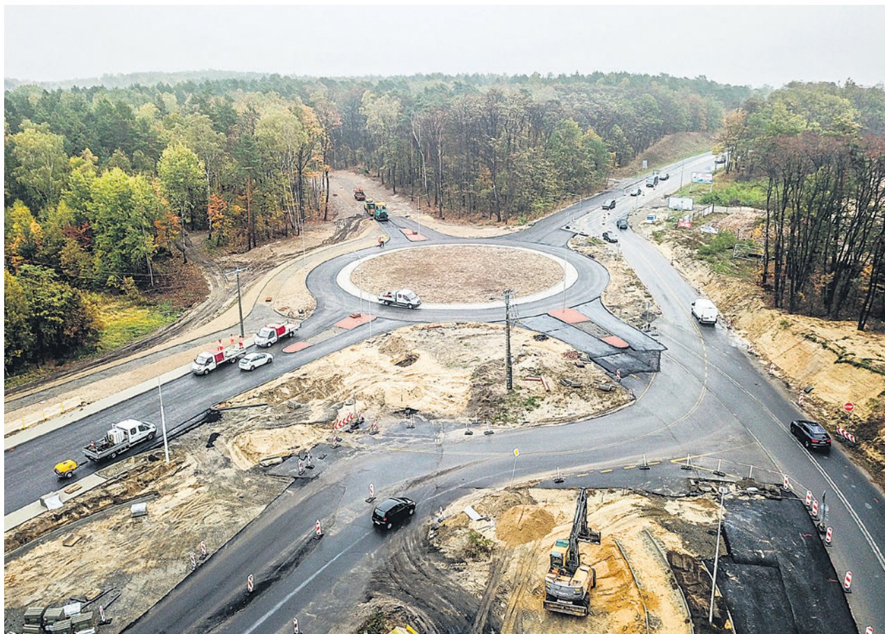
Budowa ronda na skrzyżowaniu ul. Wrocławskiej i Pileckiego
