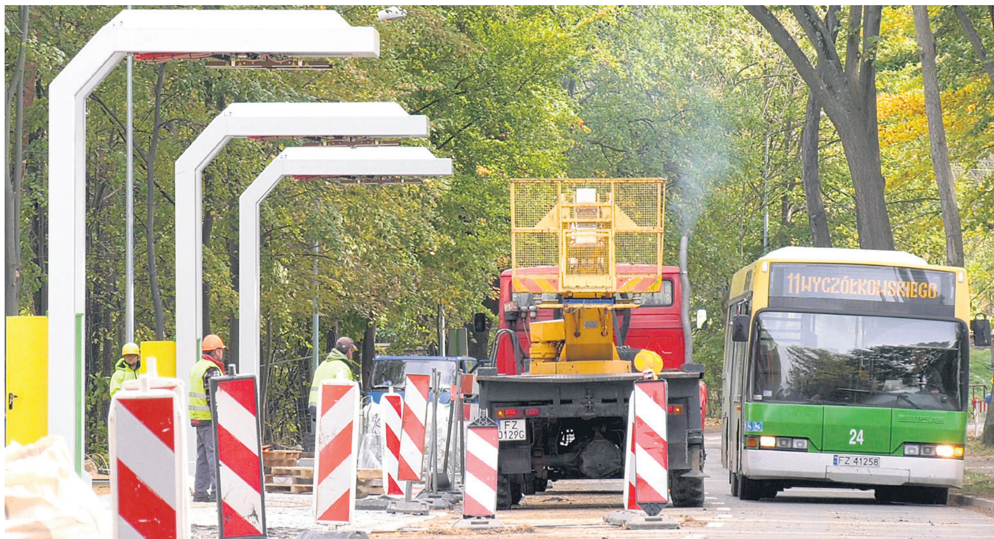
Na pętli przy ul. Wyspiańskiego powstaje pierwsza stacja ładowania elektrycznych autobusów
