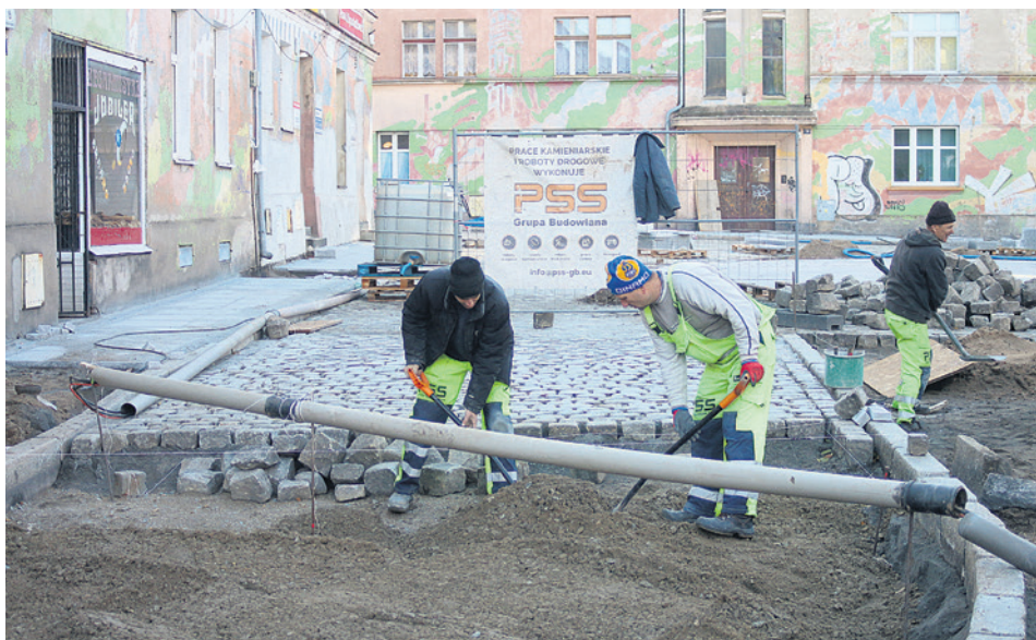
Na placu trwają intensywne prace przy kładzeniu bruku
