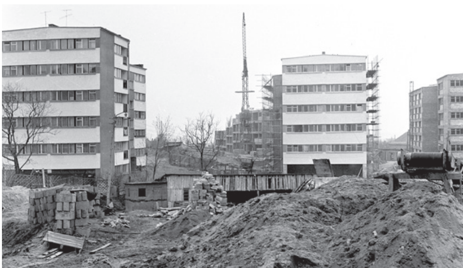
Lata 60. Budowa os. Piastowskiego
