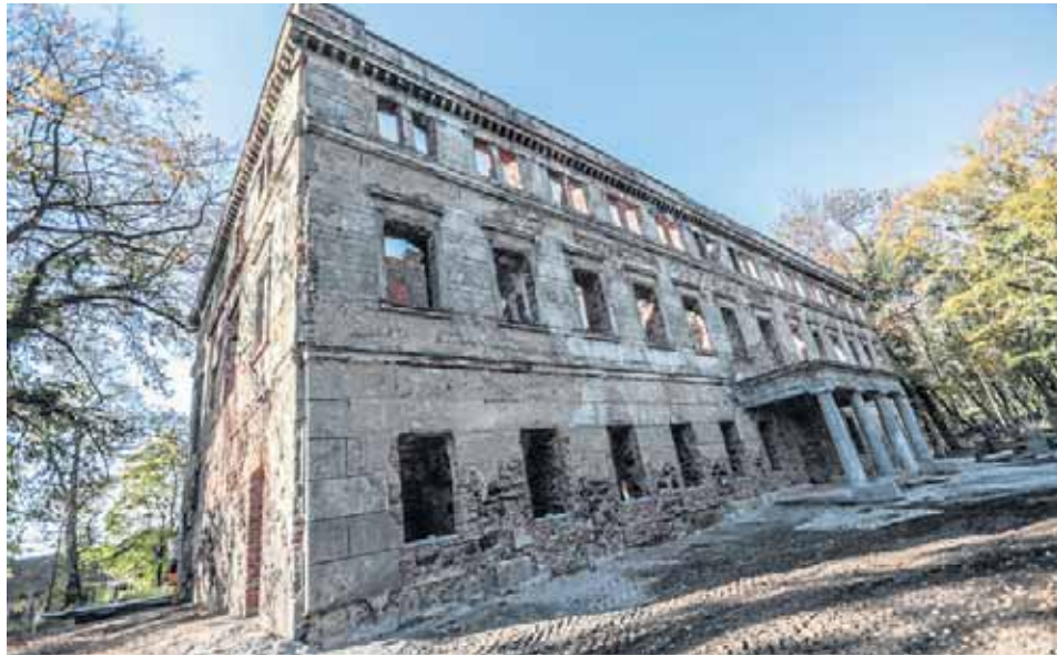
Zabezpieczenie ruin i iluminacja kosztowały 5,5 mln zł. Teraz można bezpiecznie wejść do środka.
