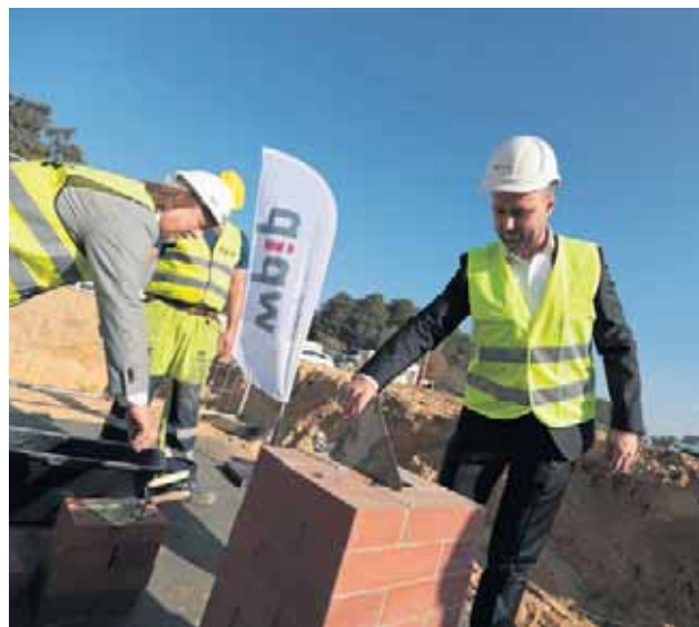
Październik 2018 r. Marcin Grzymkowski, prezes eobuwie.pl wmurowuje kamień węgielny pod centrum logistyczne.
