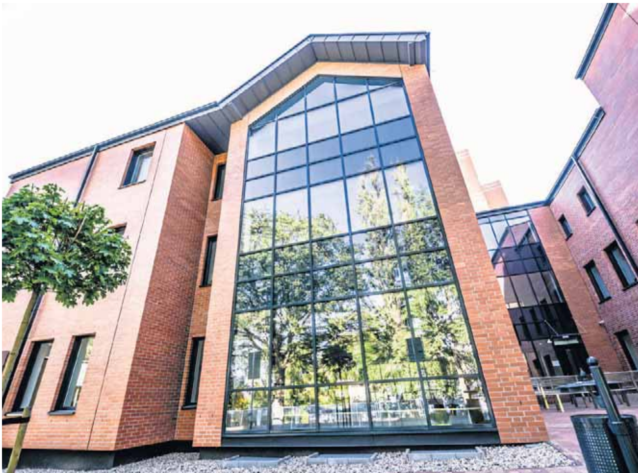
Dom Harcerza, dziś przy ul. Wyszyńskiego, zaprojektowany i zbudowany zgodnie z potrzebami placówki, to dzisiaj jeden z najładniejszych budynków w mieście
