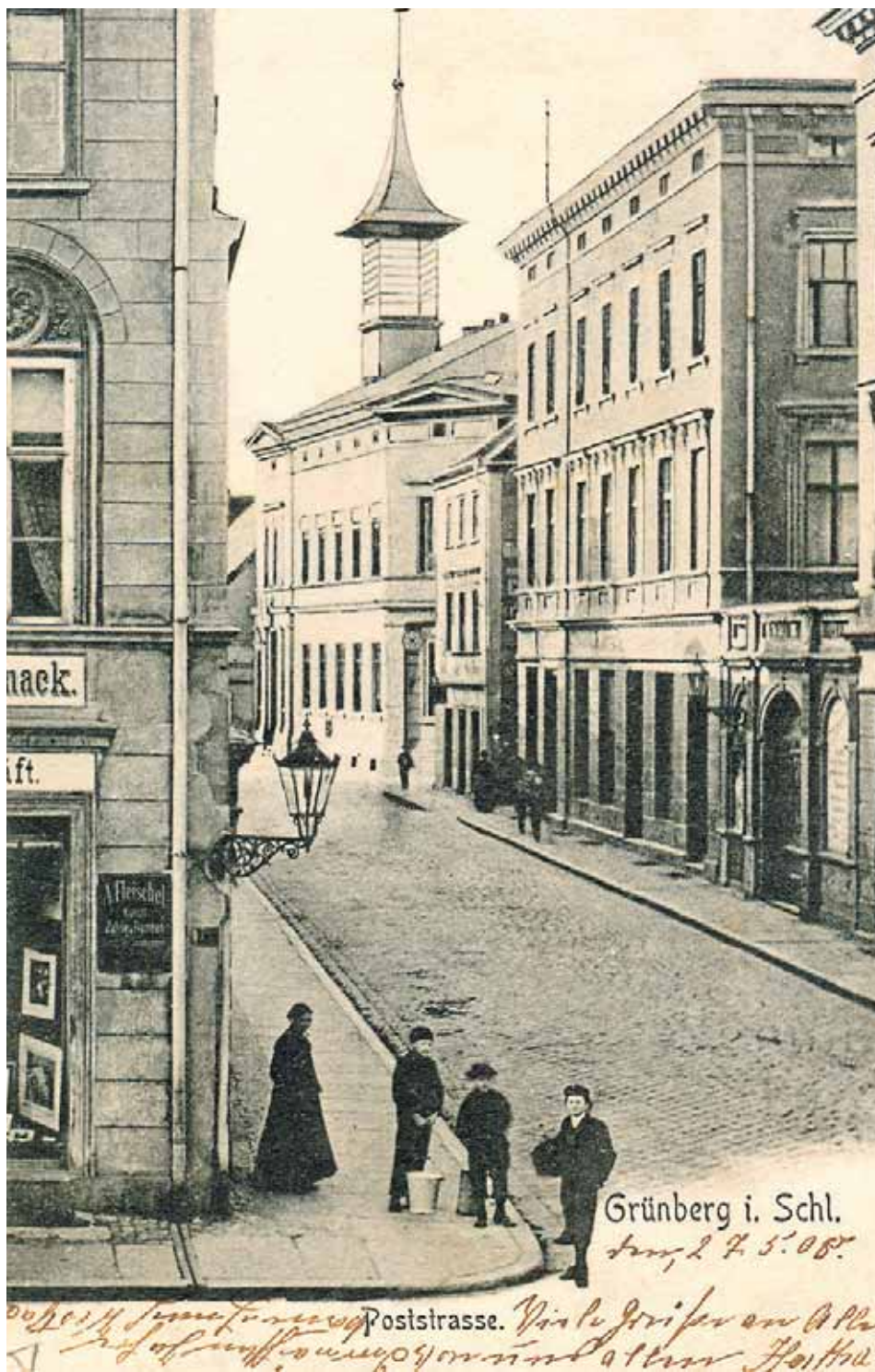
Ul. Pod Filarami ok. 1905 r. - z tyłu widać budynek poczty Ze zbiorów Sławomira Ronowicza
