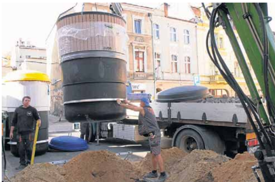
Połowa pojemnika za chwilę „schowa się” pod ziemią. Będzie widać tylko estetyczną, górną połowę z kolorową klapą. Fot. Paweł Nowak
