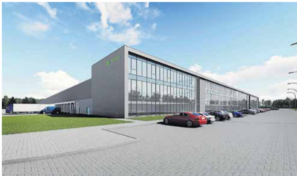
W pierwszej kolejności powstanie hala magazynowa o wysokości 12 m z trzykondygnacyjnym biurowcem Fot. Materiały firmy W.P.I.P
