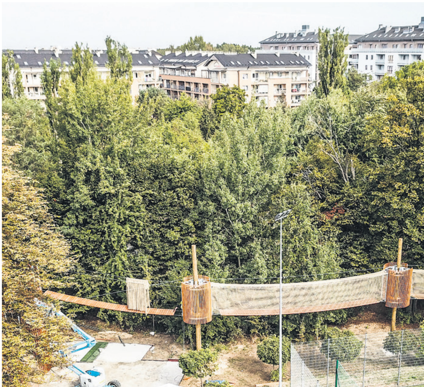
Zawieszone kilka metrów nad ziemią kładki mogą pomieścić ok. 150 osób na raz. Zamontowano je pomiędzy orlikiem przy ul. Źródlanej a pobliskim osiedlem mieszkaniowym.
