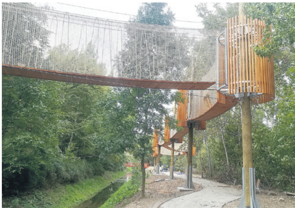
Cała trasa jest zabezpieczona specjalnymi siatkami, które chronią spacerowiczów przed upadkiem
