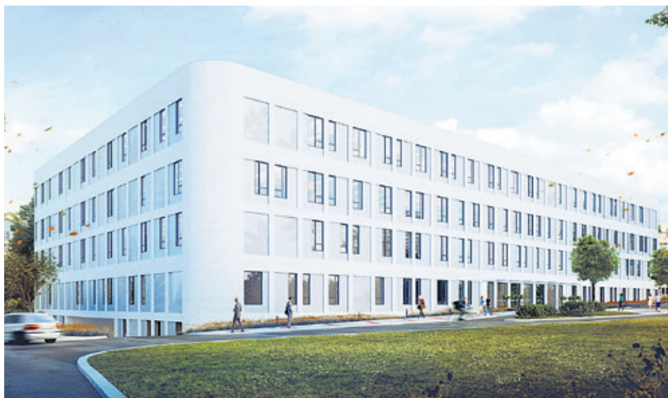
Tak ma wyglądać Centrum Zdrowia Matki i Dziecka. Koszt – 112 mln zł. W niedzielę, 23 września wkopano kamień węgielny pod budowę.
