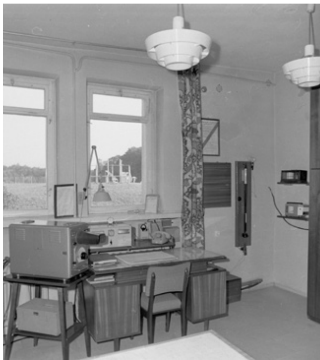
Wnętrze stacji, przy ul. Struga, oddanej do użytku w 1975 r.
