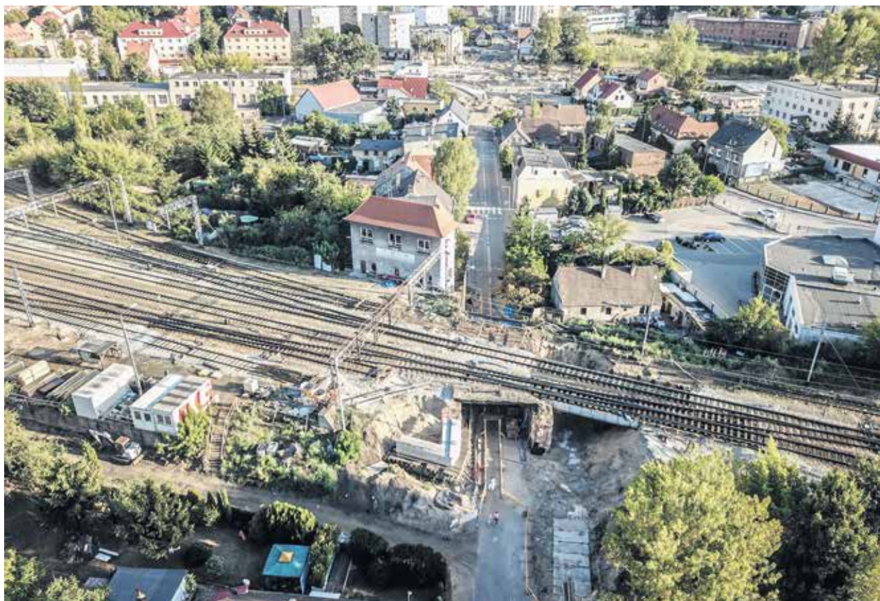
Rozebranie całego wiaduktu i postawienie nowego nie wchodzi w rachubę. Na czas remontu trzeba przebudować układ torowisk
