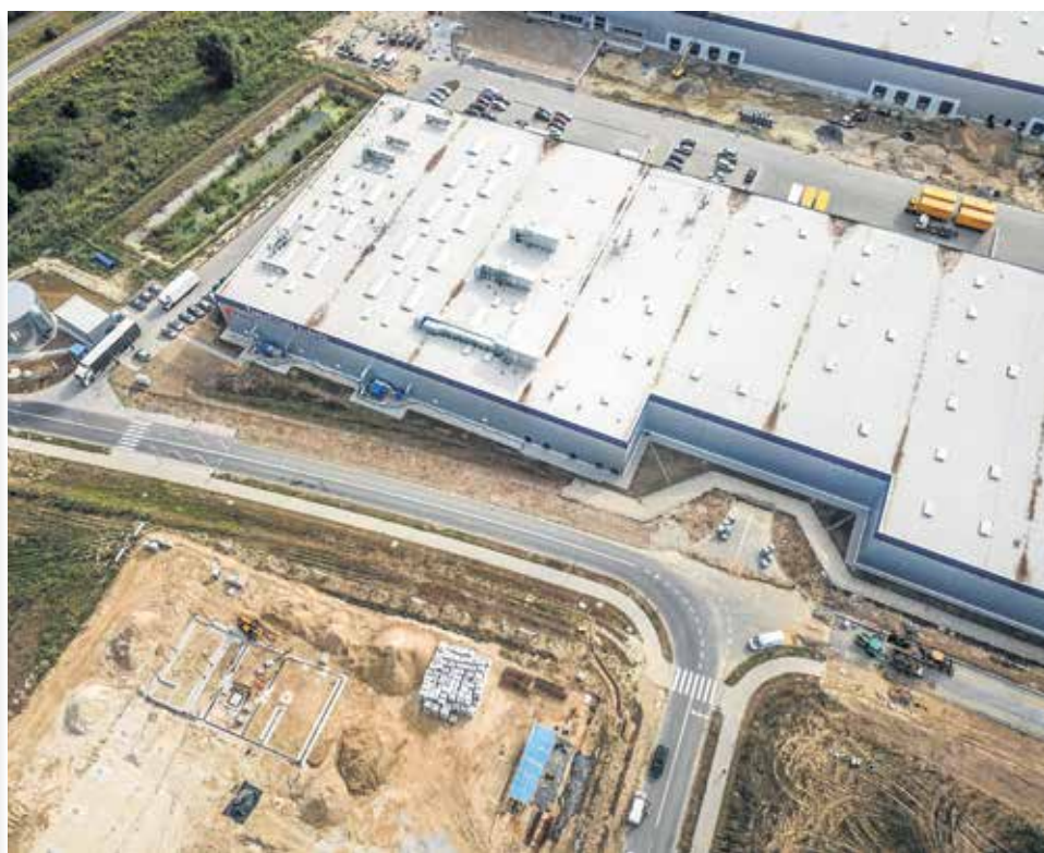
15. 16. 17. 18. Panattoni to firma budująca hale pod wynajem. W ten sposób powstają centra, w których działają zarówno firmy produkcyjne jak i logistyczne. Wstępne zapowiedzi mówiły o inwestycji w kilka hal wartych ok. 150 mln zł. Na zdjęciu gotowe hale Panattoni. Przed nimi (po drugiej stronie ulicy) trwa budowa centrum badawczego firmy Ekoenergetyka (na mapce 9).
