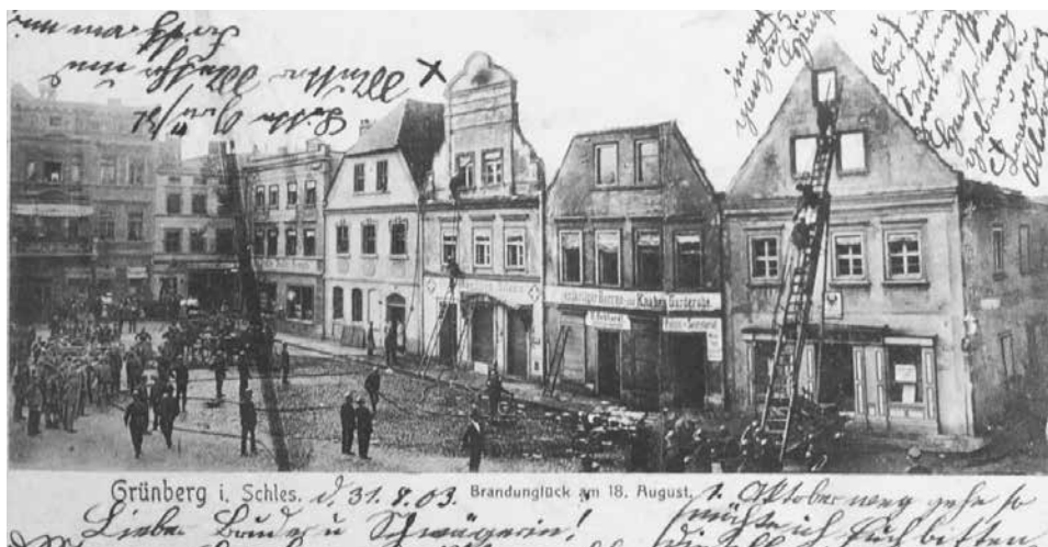
18 sierpnia 1903 r. pożar zniszczył kamieniczki po północnej stronie Starego Rynku. Trzy z nich (po prawej stronie) zburzono. W ich miejsce powstały kamienice mieszczące różne sklepy. Dzisiaj to bank PKO.
