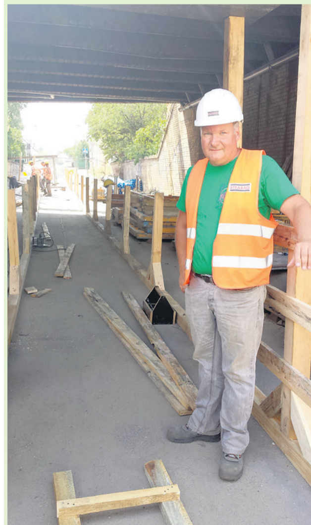
- By komuś kamień nie spadł na głowę, zrobiliśmy zadaszenie przejścia. Trzeba bowiem pamiętać, że mimo remontu, górą cały czas jeżdżą pociągi - wyjaśnia Sławomir Kaźmierczak, brygadzysta spółki Strabag. Fot. Archiwum „ŁZ”
