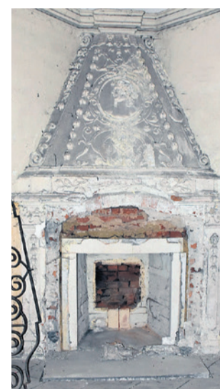
Jeden z zachowanych kominów na parterze.
