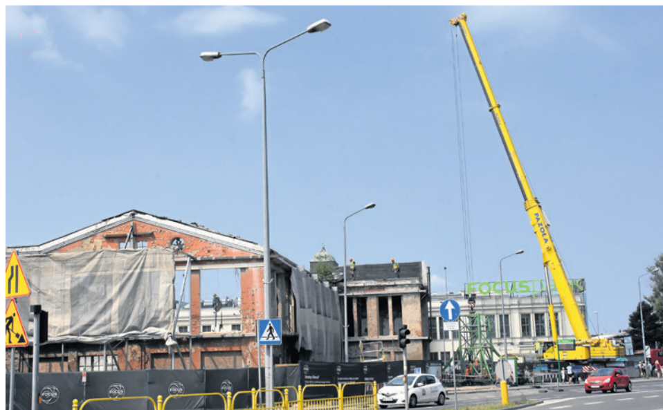
Widok od ul. Wrocławskiej. Ściany zewnętrzne zostaną odnowione.
