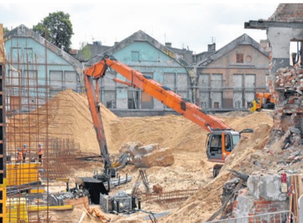
W środku widać głębokie wykopy m.in. pod zbiornik retencyjny
