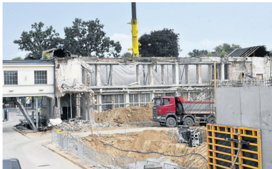
Ściany zostały zabezpieczone przed upadkiem
