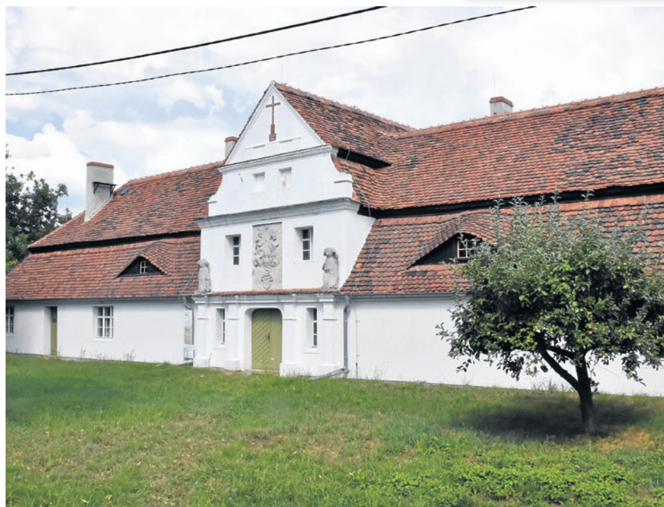
Wracając z zamku, warto się na chwilę zatrzymać przy dawnym barokowym szpitalu z piękną płaskorzeźbą. Powstał w 1765 r.
