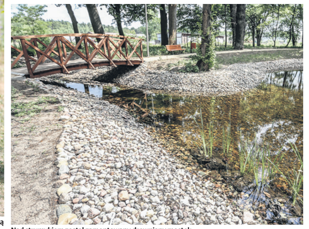
Nad strumykiem został zamontowany drewniany mostek
