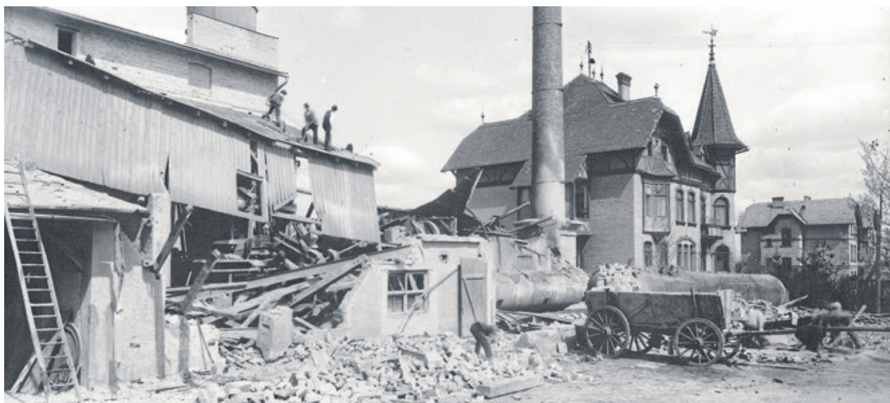
W tym domu przy ul. Głowackiego zamieszkali państwo von Höften. Trwa wyburzenie sąsiednich zabudowań fabrycznych (na pierwszym planie).
