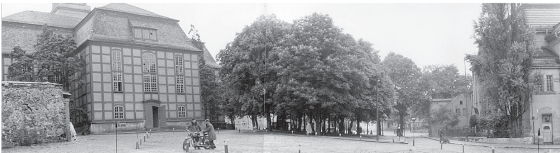
Rok 1960. Widok na pl. Powstańców Wielkopolskich i Dom Katolicki od strony ul. Kupieckiej
