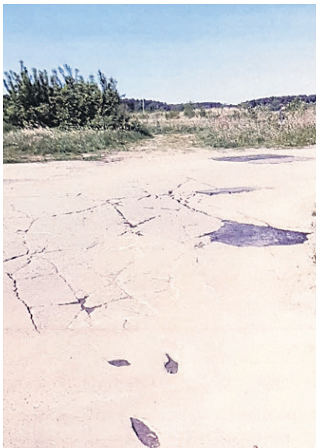
Okręg V, zadanie: Modernizacja drogi na os. „Na Olimpie”
