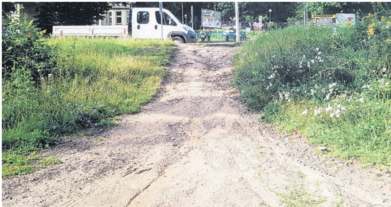
Okręg IV, zadanie: Budowa schodów na skarpie przy przejściu na rondzie Bandurskiego
