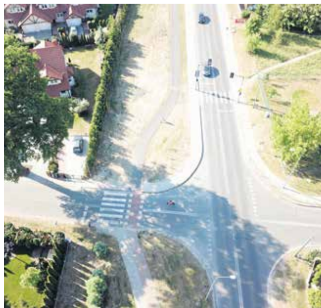
Budowa rowerostrady Zielona Strzała - odcinek przy ul. Nowojędrzychowskiej
