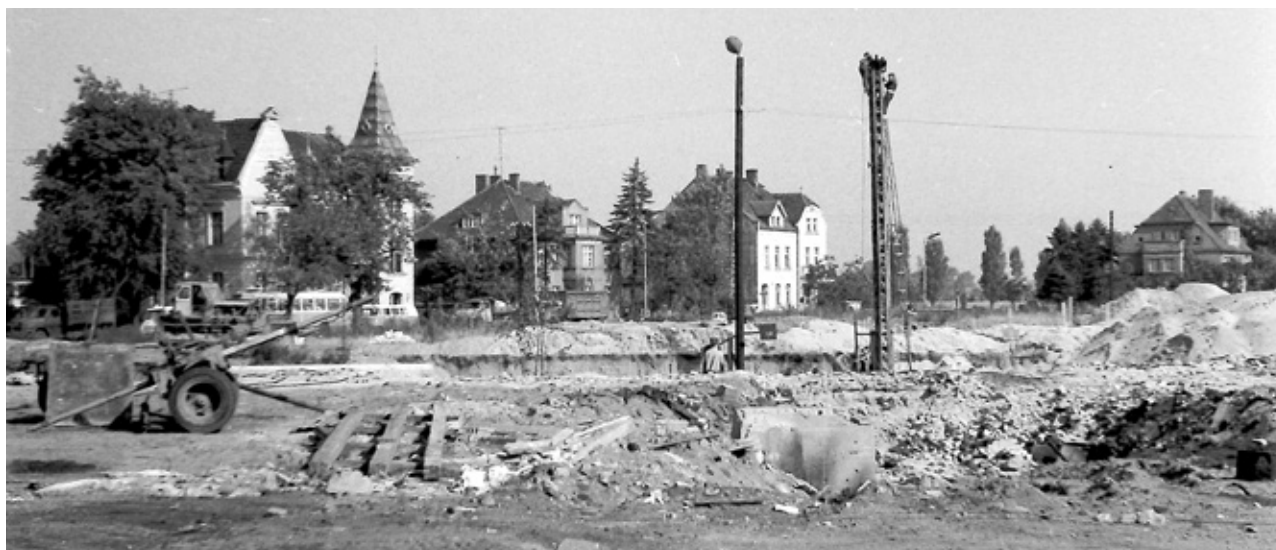
Przygotowania do budowy wiaduktu – zrównano teren przy torach kolejowych
