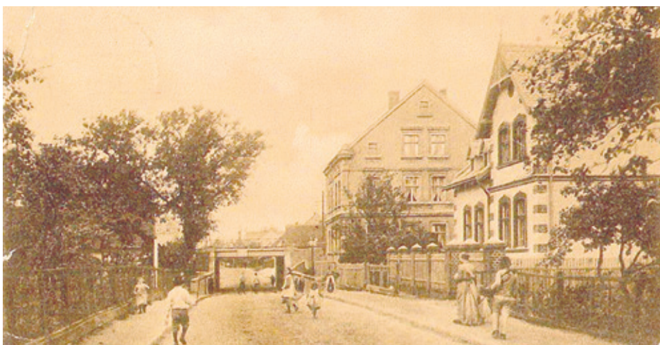
Wiadukt nad ul. Batorego powstał wraz z linią kolejową otwartą w 1871 r.
