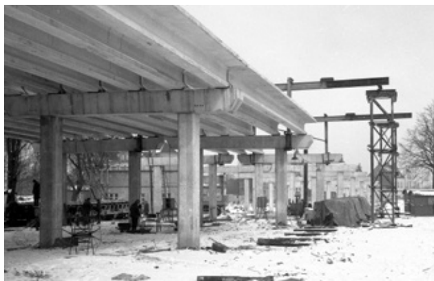
Montaż przęseł na betonowych podporach
