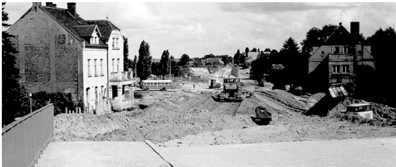
Wiadukt został już przerzucony nad torami, trzeba jeszcze zbudować zjazd na ulicę
