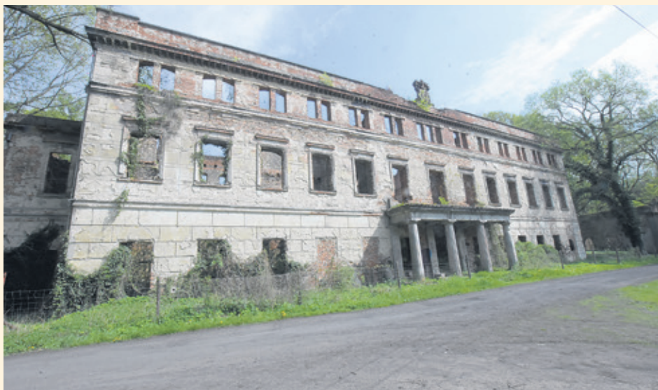
Ruiny pałacu zostaną zabezpieczone i podświetlone
