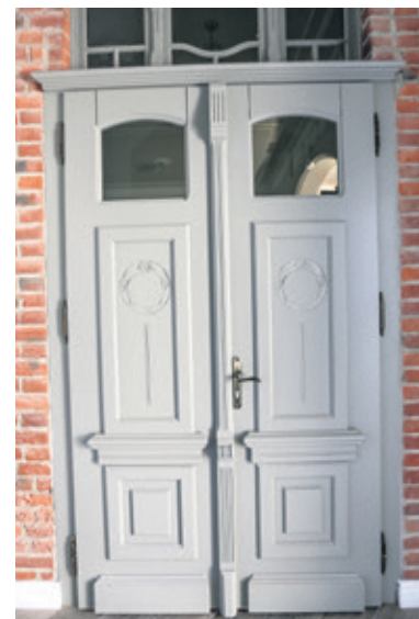
Zachowano stare drzwi wejściowe, które zostały odnowione z wielkim pietyzmem
