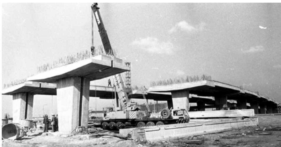
Wrzesień 1977 r. – budowa wiaduktu nad ul. Zjednoczenia – widok z Dąbrowskiego
