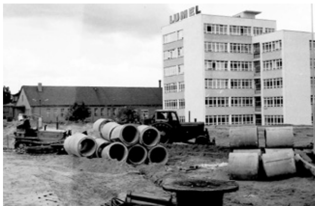
Przy okazji budowy wiaduktu, przebudowano również ul. Wypiańskiego
