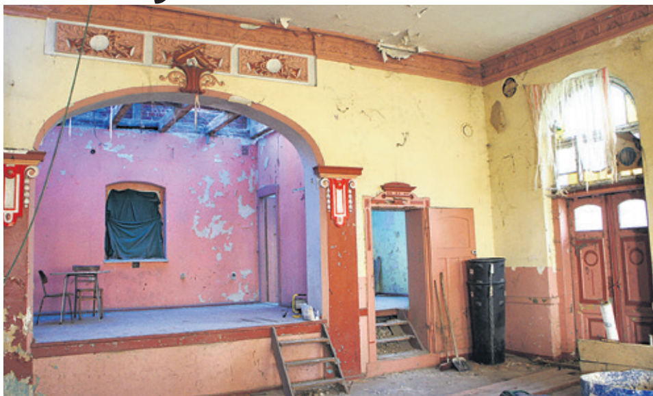
Tak wyglądała sala ze sceną przed rozpoczęciem remontu
