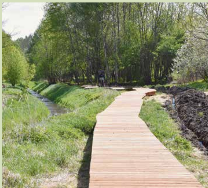
Dolina Gęśnika. Tutaj wciąż trwają prace. Kształt wielu zadań „wymusza” płynący doliną strumień. Część biegnących tutaj ścieżek spacerowych będzie miała kształt pomostów.
