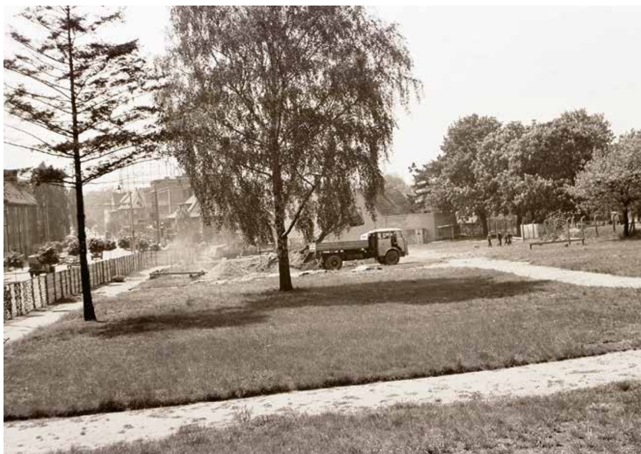
Rok 1965. Na plac budowy wjeżdża pierwsza wywrotka. Tutaj stanie Klub MPiK. W oddali widać konstrukcję gazowni.
