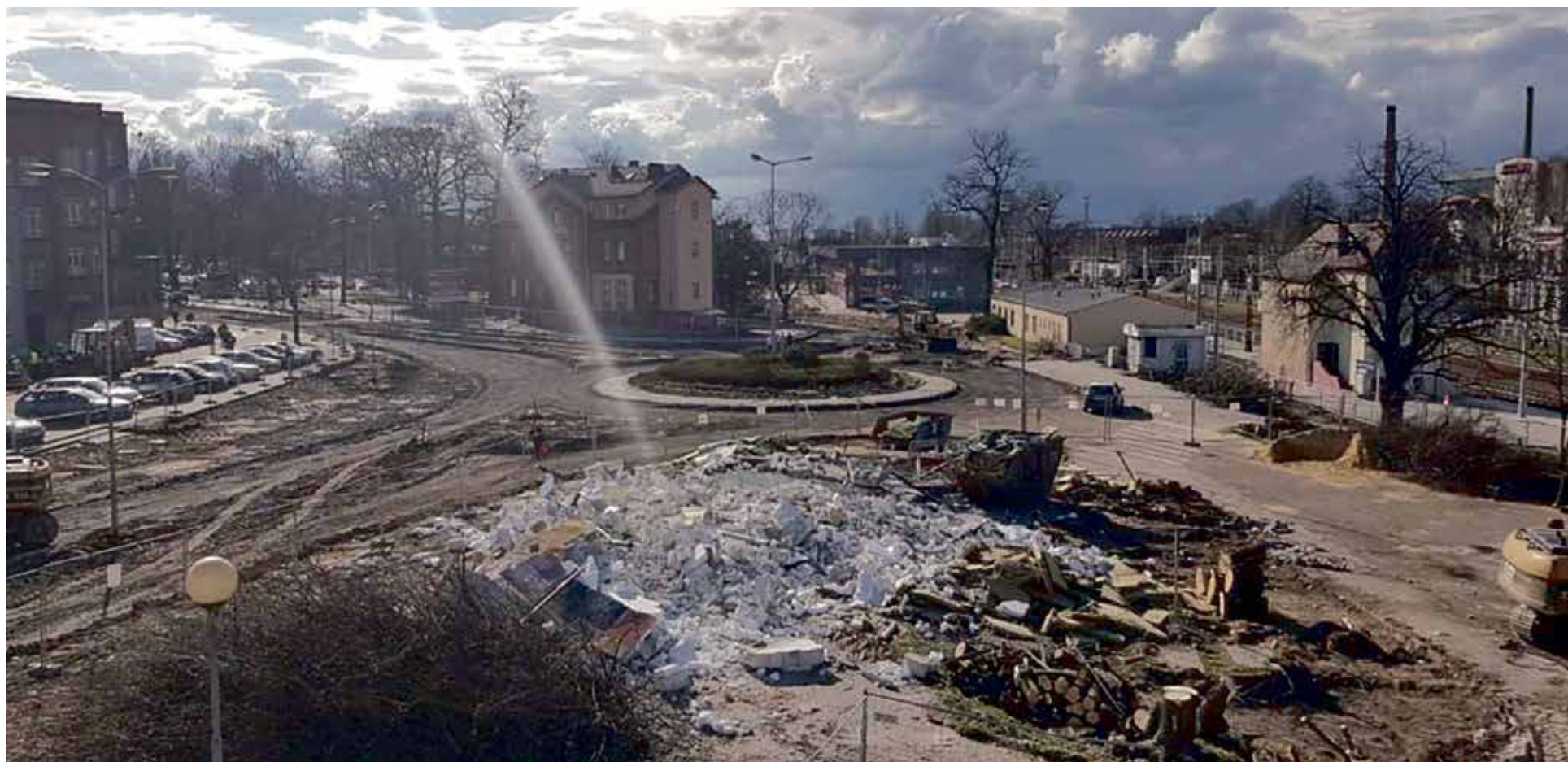
Rondo Maćkowiaka koło dworca PKP – tutaj powstanie centrum przesiadkowe. Na razie trwają prace wyburzeniowe.
