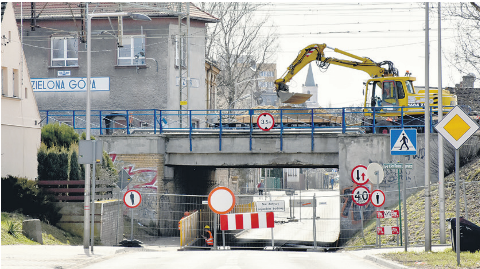
Stop, koniec drogi! Pod wiaduktem nie przejdą piesi, nie przejadą samochody. Remont potrwa do jesieni.
