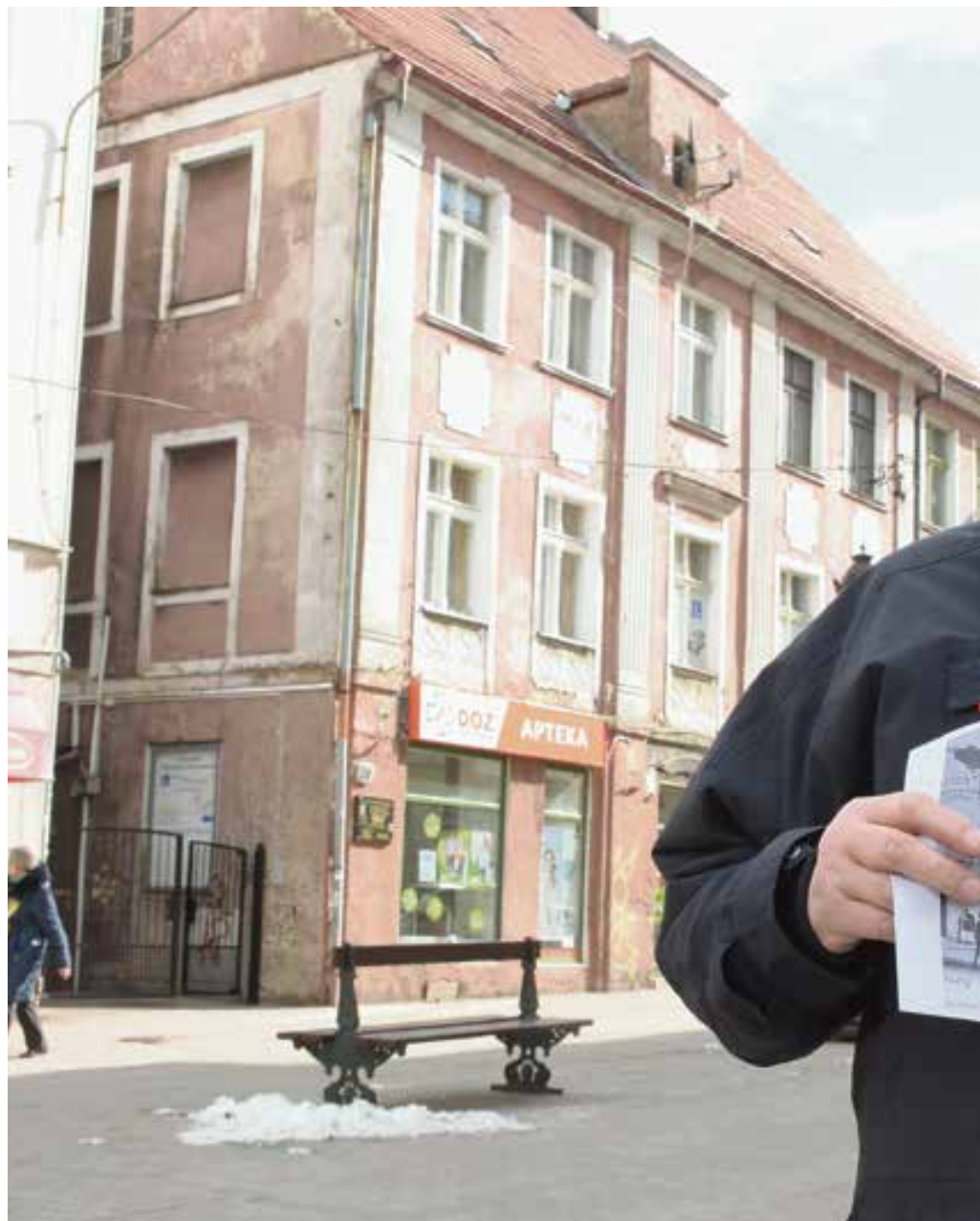
- Ten budynek ma 200 lat. Odnowimy całą elewację – mówi Edward Nalepa i pokazuje na pocztówce.
