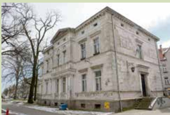
Kamienica przy al. Niepodległości 35 – widok obecny Fot. Krzysztof Grabowski
