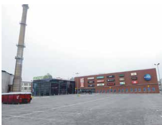
Na miejscu obecnego parkingu powstanie zupełnie nowa część galerii - kondygnacje z parkingami umieszczone zostaną naprzemiennie z handlowymi
