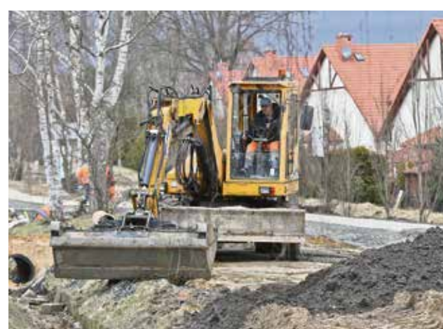
Ul. Nowojędrzychowska. Trwa budowa ścieżki rowerowej wzdłuż drogi. Czekają na nią rowerzyści i mieszkańcy okolicy. Zdjęcia Piotr Jędzura
