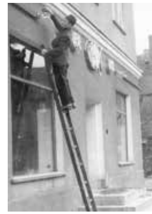
Montaż neonu sklepu Karaś Fot. Bronisław Bugieł
