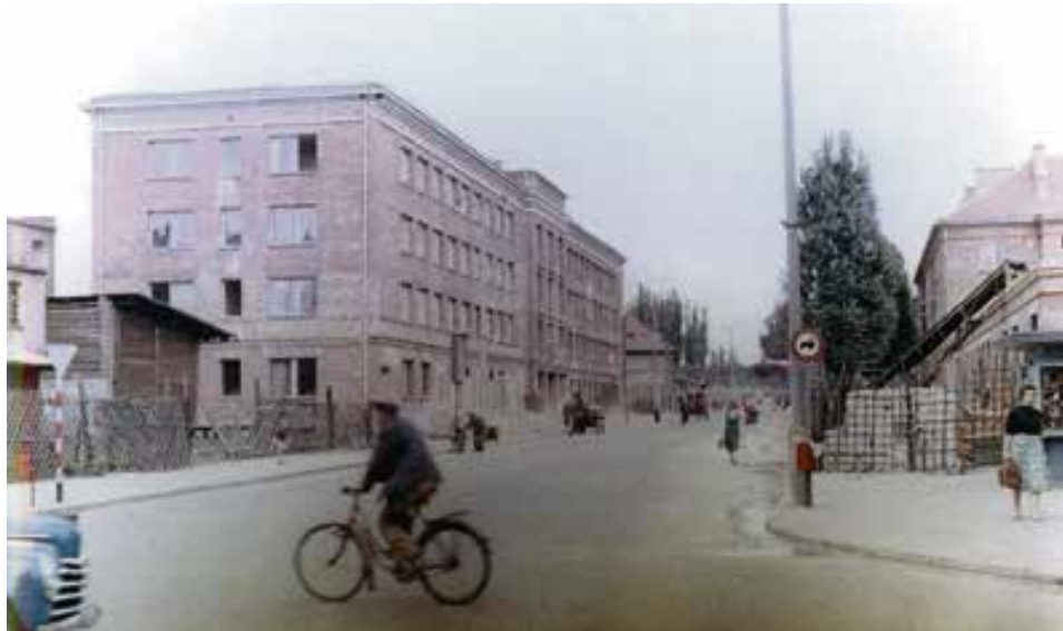
Skrzyżowanie Bohaterów Westerplatte z dzisiejszą Kupiecką w 1958/59 r. Trwa budowa domów po obu stronach ulicy Fot. Jerzy Topolski
