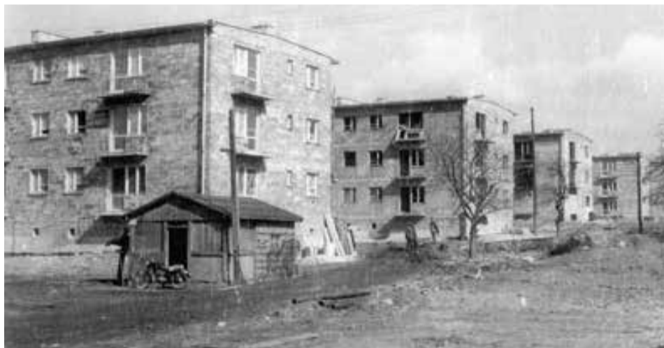
Powstają pierwsze domy mieszkalne przy ul. Staffa - 1960 r.
