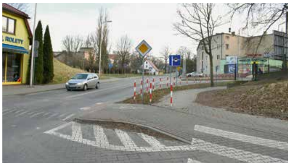
W tym miejscu stanie nowy wiadukt nad ulicą
