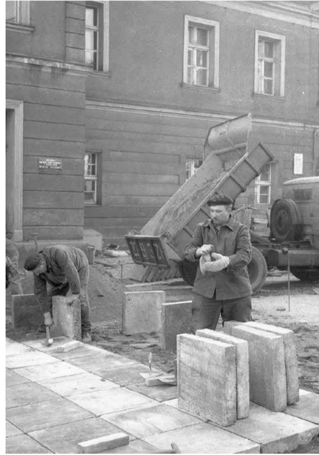
Deptak powstawał etapami. Najpierw wyłączono z ruchu ul. Żeromskiego. Później przyszła kolej na Stary Rynek (wówczas Boh. Stalingradu). Fot. Bronisław Bugiel
