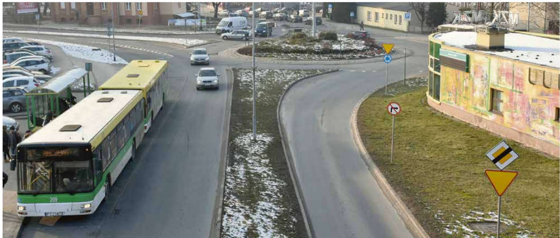
Wraz z remontem ul. Dworcowej, czeka nas przebudowa ronda Maćkowiaka (prace rozpoczną się 12 marca) i rozbiórka budynku MZK
