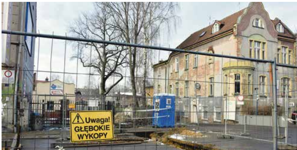
Po zakończeniu budowy pl. Teatralnego zmieni się również fragment pl. Matejki. W tym miejscu stanie forma przestrzenna poświęcona odzyskaniu niepodległości przez Polskę.
