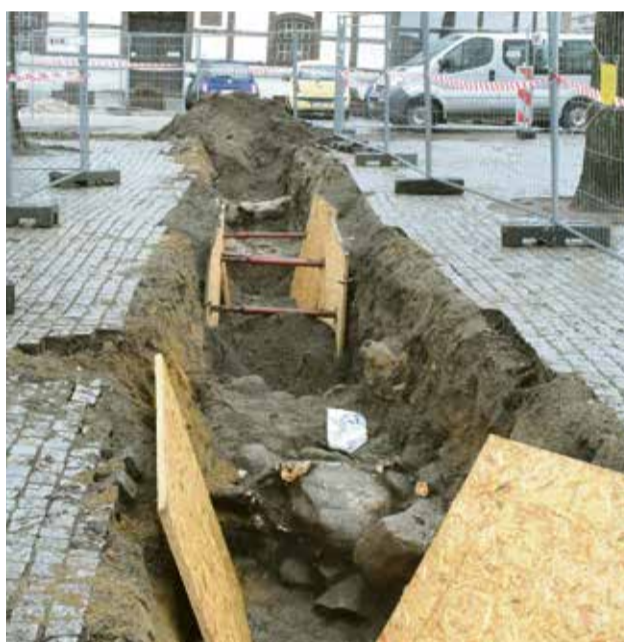
Wykop, w którym odkryto stare fundamenty. Na pierwszym planie resztki murów obronnych, w głębi fundamenty zburzonych kamienic. Tomasz Czyżniewski
