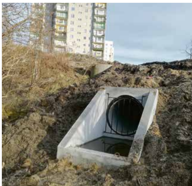
Końcówka przepustu pod al. Zjednoczenia. Tędy przepływa nadmiar Złotej Łączy, który na razie trafia do kanalizacji. Fot. Tomasz Czyżniewski
