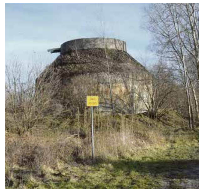
Dawna oczyszczalnia ścieków, przy ul. Folszowej. Nad okolicą góruje dawna komora fermentacyjna do osadów, wytwarzająca biogaz. Fot. Tomasz Czyżniewski
