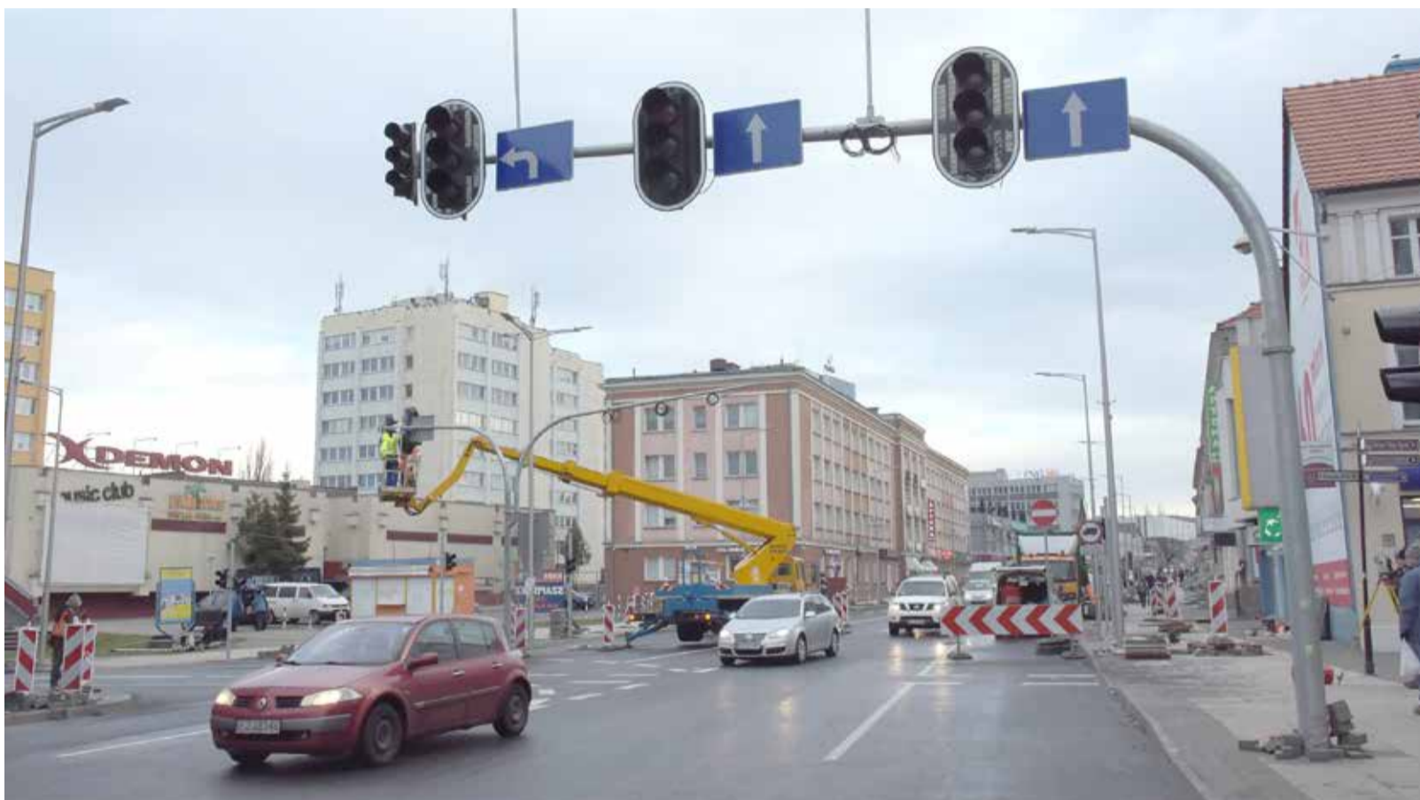
Do ostatniej chwili trwały prace na remontowanej ulicy. Na zdjęciu: montaż sygnalizacji świetlnej.
