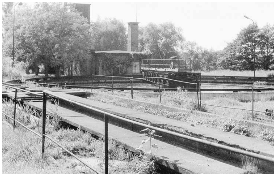
Lata 70. Oczyszczalnia ścieków z osadnikiem mechanicznym. Zdjęcie udostępnione przez Barbarę Fröhlich Sarnę. - Aleksander Snopek to mój szwagier. Kiedyś podarował mi swoje zbiory. Od dziecka chodził po mieście i je fotografował - opowiada pani Barbara. - Pracował w biurze architektonicznym. Wykorzystywał te zdjęcia do prac projektowych. Fot. Aleksander Snopek
