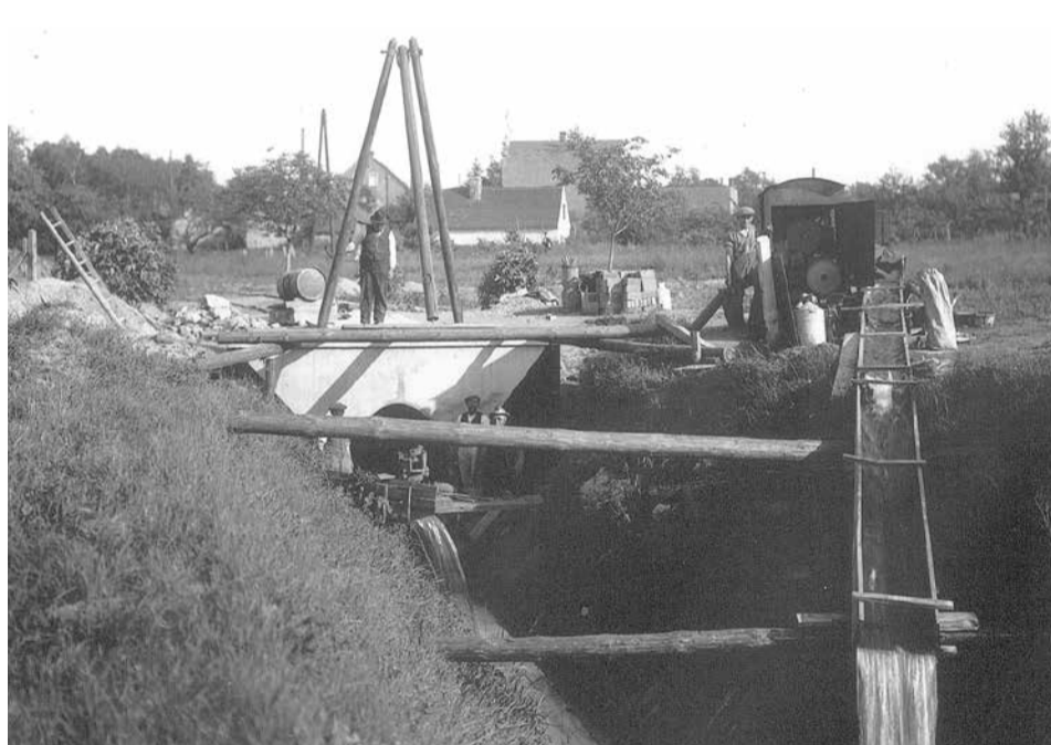
Lata 20. XX wieku - budowa kanalizacji. Przykryty kanał ściekowy łączy się z otwartym kolektorem prowadzącym do oczyszczalni. Ze zbiorów Muzeum Ziemi Lubuskiej
