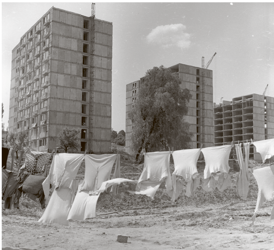
Gdy budowano wieżowce przy ul. Dzierżyńskiego (dzisiaj Władysława IV), w domach przy Podgórnej mieszkali już ludzie. Stąd pranie na budowie. Fot. Bronisław Bugiel
