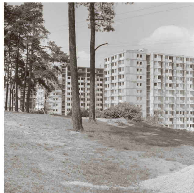
Budowane wieżowce widziane od strony parku
