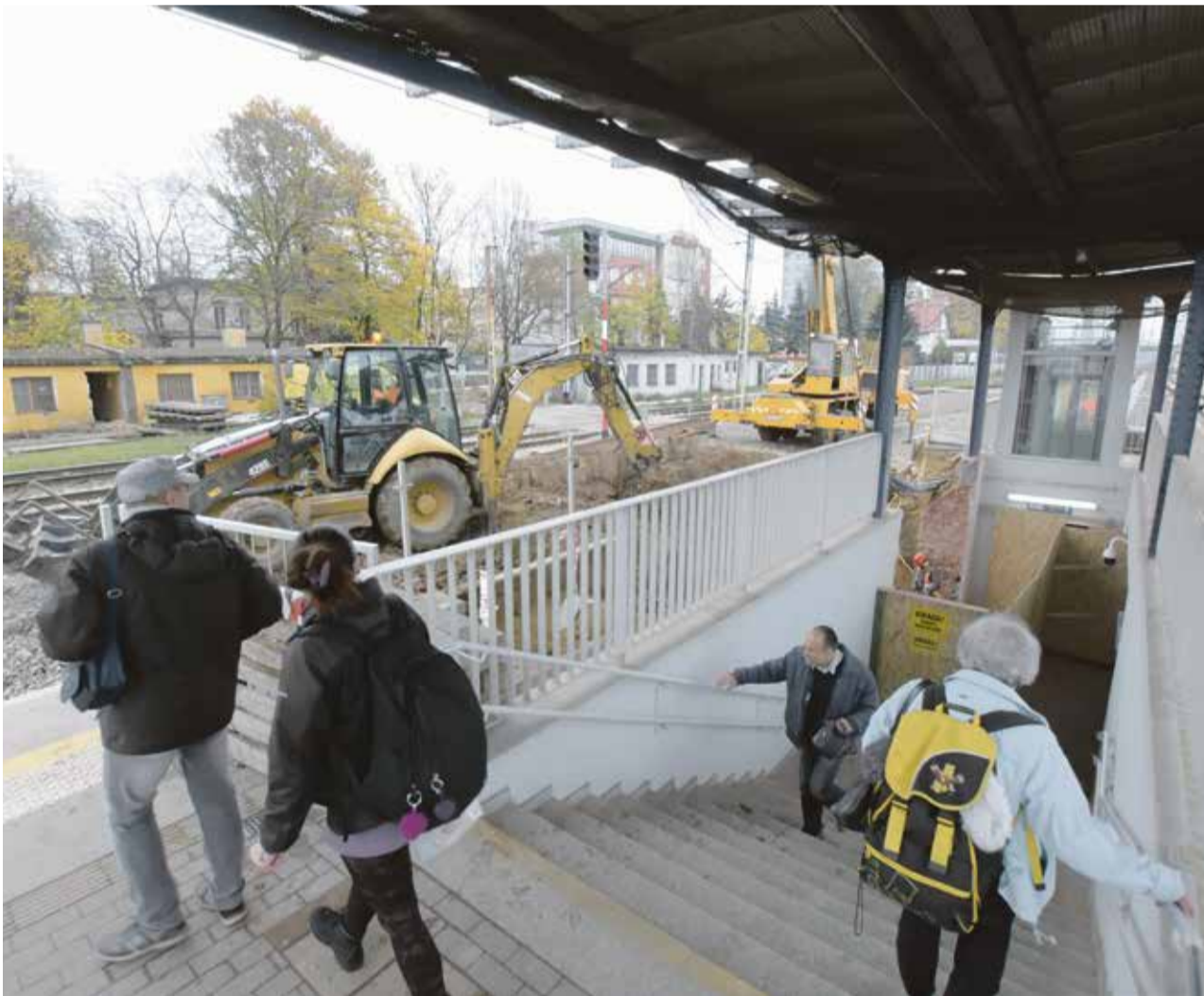
Ruszyły prace pod torami! Obecny tunel zostanie przedłużony o ponad 24 metry. Zapewni mieszkańcom i podróżnym wygodne oraz bezpieczne przejście między ul. Dworcową i Towarową. Fot. Krzysztof Grabowski
