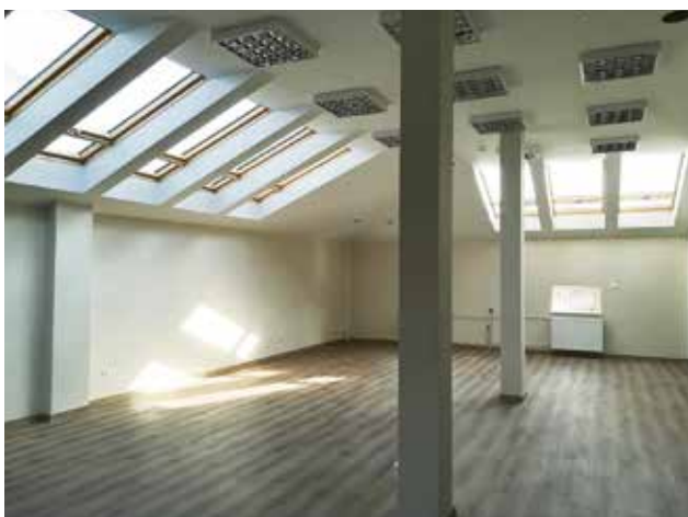
W dawnej sali balowej zachowano elementy starych dekoracji
