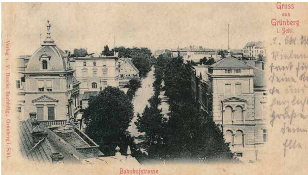
Al. Niepodległości w połowie lat 90. XIX w. Po prawej gmach muzeum. Po lewej nie ma jeszcze wielu budynków.
