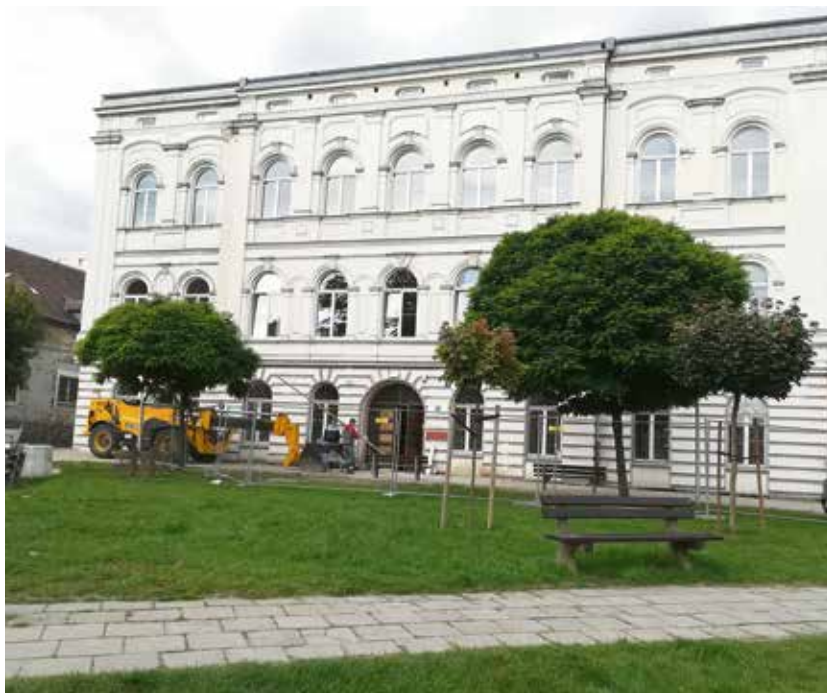
Budynek przy pl. Słowiańskim - prace zakończy planowany remont elewacji
