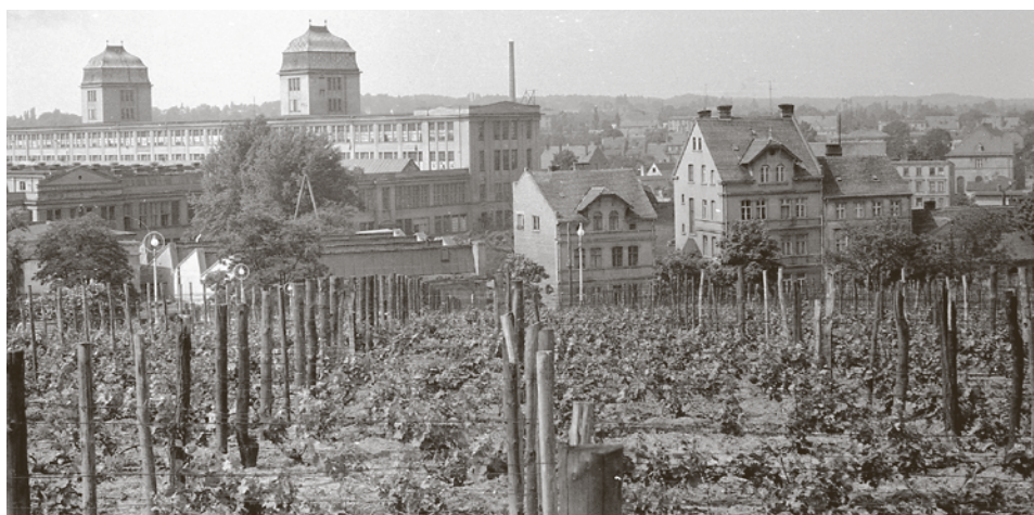
Chcąc połączyć al. Konstytucji 3 Maja z ul. Wrocławską, trzeba było wyburzyć kilka kamienic. Widok z Palmiarni.
