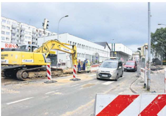
Na ul. Boh. Westerplatte praca wre. Piesi i zmotoryzowani już przyzwyczaili się do obecności maszyn i budowlanców oraz utrudnień, które towarzyszą remontowi.
