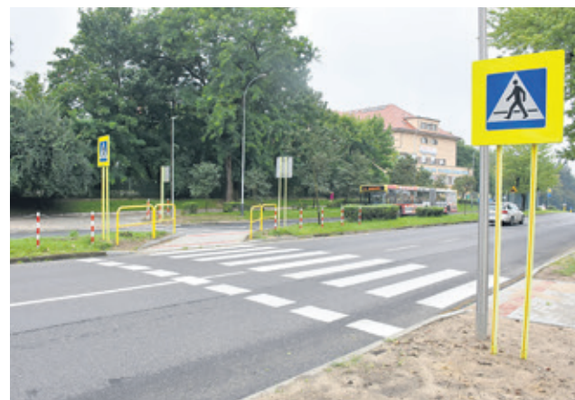
Zlikwidowano niebezpieczne przejście dla pieszych przy ul. Waryńskiego, na wysokości tzw. „medyka”. Nowe pasy znajdują się sto merów wyżej, bliżej zatoczki autobusowej.
