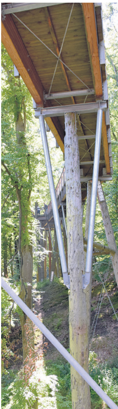
Konstrukcja, na której zawieszona jest kładka, miejscami osiąga 14 m wysokości. Umiejętnie wykorzystano tu naturalne ukształtowanie terenu, stalowe podpory zamontowano na daglezjach i modrzewiach.
