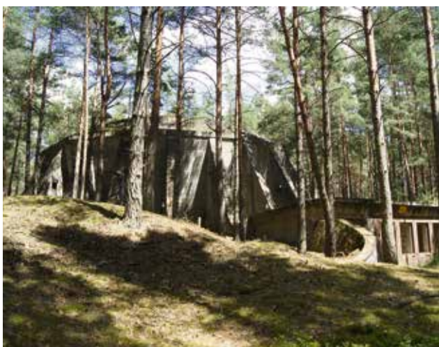
Zbiornik na etanol widziany z zewnątrz
