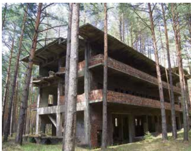
Budynek nitracyjny z charakterystycznymi balkonami
