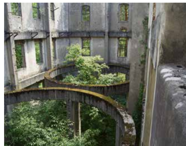
Budynek ostatecznego oczyszczania wody
