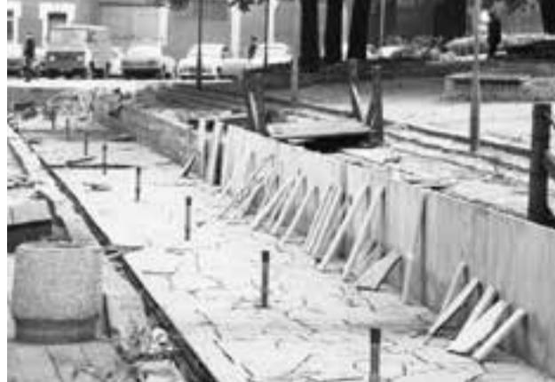
Rok 1979. Zdemontowano mostki i trwa wykładanie niecki płytami z marmuru.
