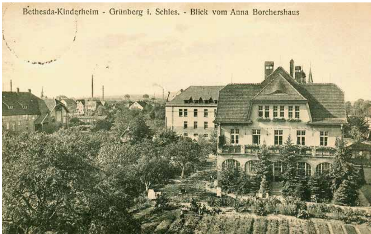
Przedszkole przy ul. Wazów - widok z okien medyka
