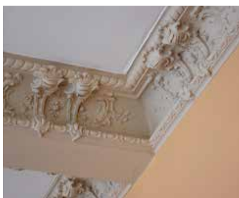
Gzymsy w sali balowej skutecznie zasłaniają stalowy dwuteownik podtrzymujący strop
