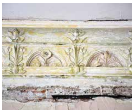
Wiele pracy będzie wymagało odnowienie dekoracji w sali na drugim piętrze budynku
