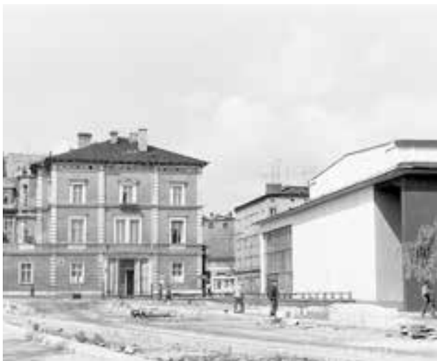
Jako ostatni zburzono budynek przychodni. Po prawej kino Wenus. Fot. Zbigniew Rajche
