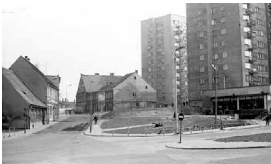
Drugi koniec nowej arterii - widok od strony Długiej. Kamienice po prawej stronie Srebrnej Góry przeznaczone do wyburzenia. Fot. Zbigniew Rajche
