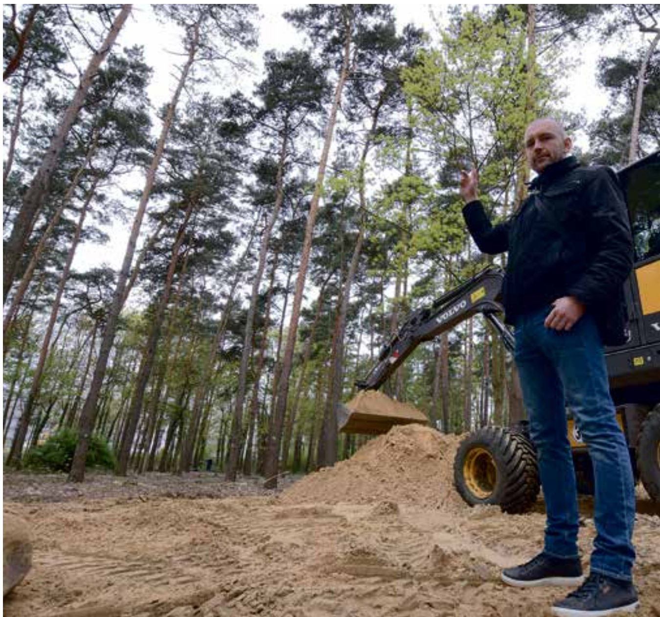
- W tym miejscu stanie wieża widokowa. Będzie miała 12 m wysokości - pokazuje Andrzej Rosiński
