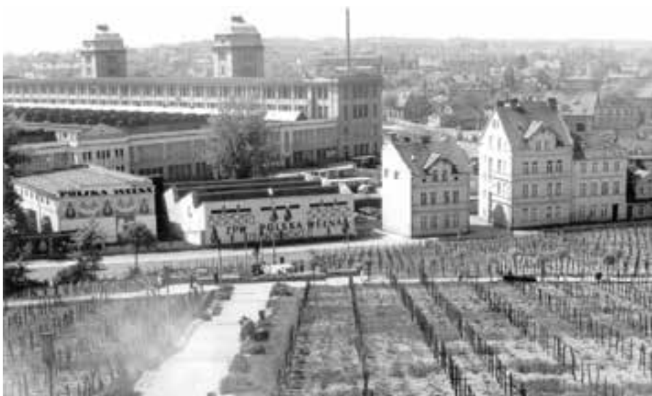
Widok z Winięty - żeby przebić się do ul. Wrocławskiej, trzeba było zburzyć kilka kamienic Fot. Bronisław Bugiel
