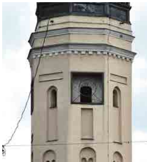
Demontaż zegara odsłonił stare otwory okienne
