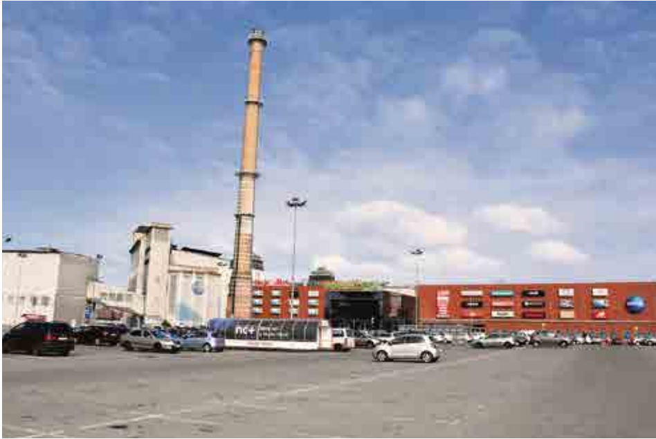
Inwestor planuje, że w tym miejscu powstaną wielopoziomowe sklepy i parkingi
