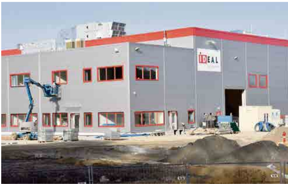
W innym miejscu Lubuskiego Parku Przemysłowo-Technologicznego dobiega końca budowa fabryki Ideal Automotive
