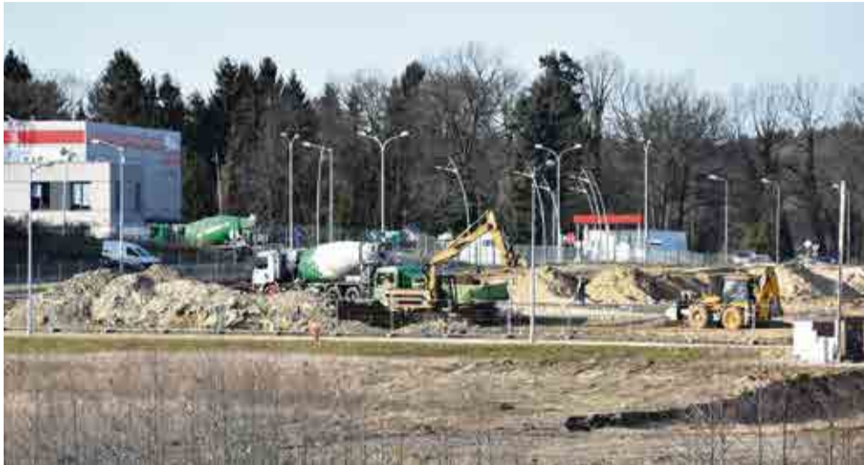
Rozpoczęły się roboty ziemne przy budowie nowej fabryki firmy Styropmin
