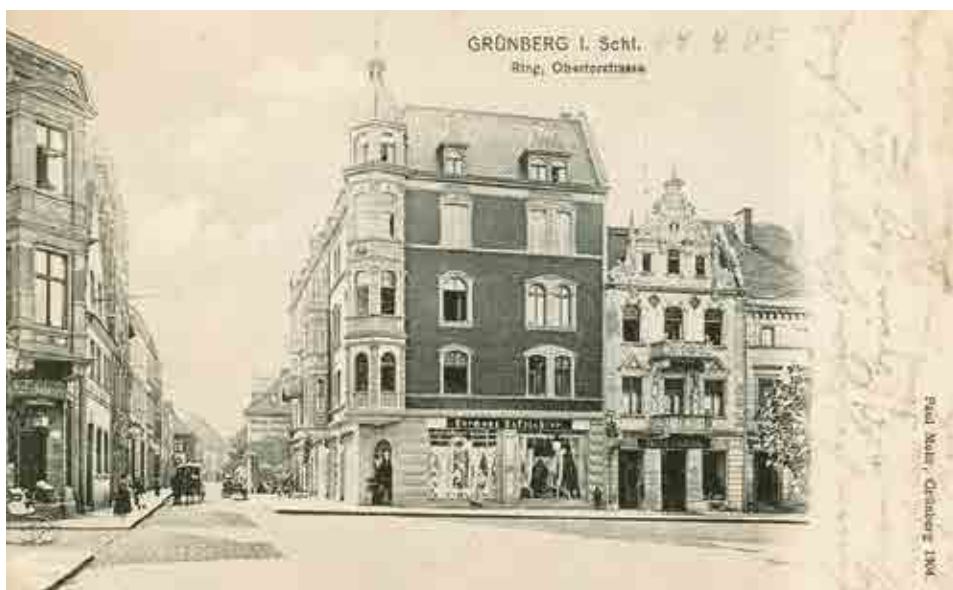
Budynek na rogu ul. Sobieskiego i Starego Rynku został zniszczony w 1945 r. przez pożar, który wypalił wnętrze. Na początku lat 50. postawiono w tym miejscu budynek, w którym dzisiaj mieści się bank BGŻ. Ze zbiorów Sławomira Ronowicza
