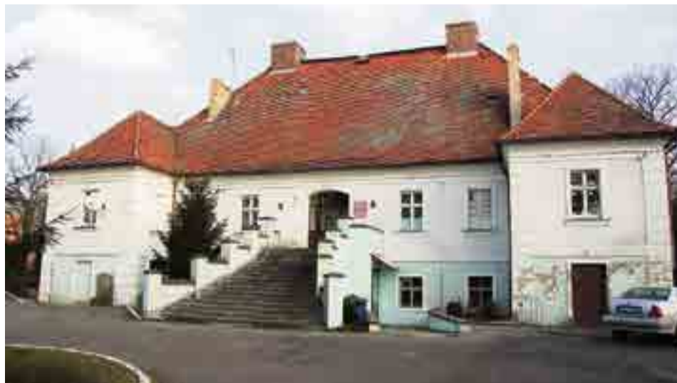
W zabytkowym, XIX-wiecznym dworku w Kruszynie dziś mieści się Centrum Usług Socjalnych. W ramach planowanego na 2017 r. remontu obiektu zostałyby naprawiony jego dach, wymieniona stolarka drzwiowa i okienna wraz z podokiennikami, zmodernizowana kotłownia i instalacja centralnego ogrzewania. Wartość zadania obliczono na około 2,3 mln zł., a unijne dofinansowanie na prawie 2 mln zł. Fot. UM Sulechów
