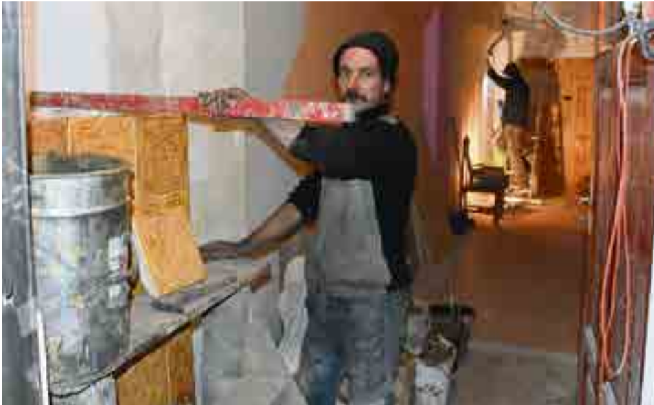
Paweł Superson zajął się piecem kaflowym. W jego rękach stare urządzenie nabiera nowych kształtów. - Będzie nie tylko ozdobą, ale też dogrzeje pomieszczenia - tłumaczy zdun.
