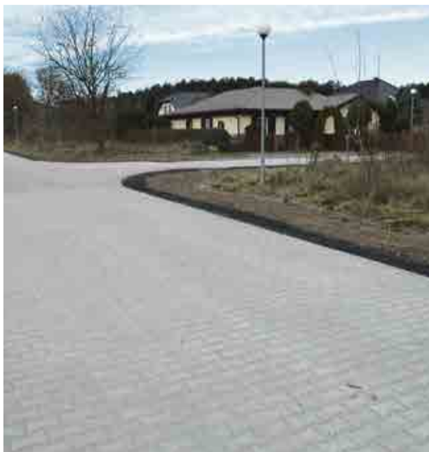
Polbruk zamiast gruntowej, pełnej wybojów drogi. Kalosze idą w odstawkę. Fot. Urząd Gminy Zabór
